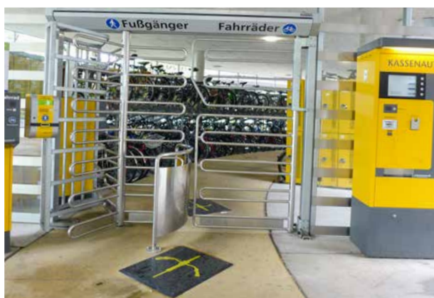
Drehkreuzanlage in Freiburg
