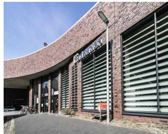
Eingangsseite der Radstation in Bergedorf
